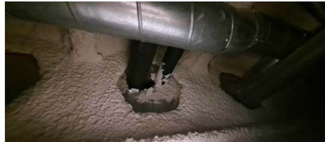
Vista interior de fals sostre amb viga Boyd
